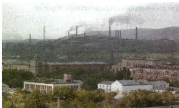
Магнитогорский металлургический комбинат. Дымят мартиновские печи...
