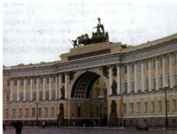
Санкт-Петербург. Триумфальная арка Главного штаба
